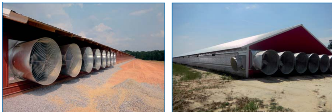
Figura 40: Primer tipičnog objekta sa tunel ventilacijom.
